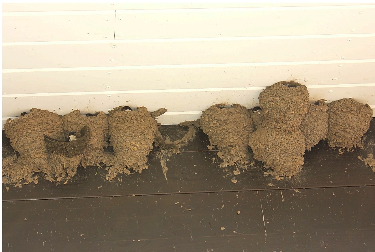
Рис. 31. Фрагмент здания «Беседки» с гнездами воронков.
